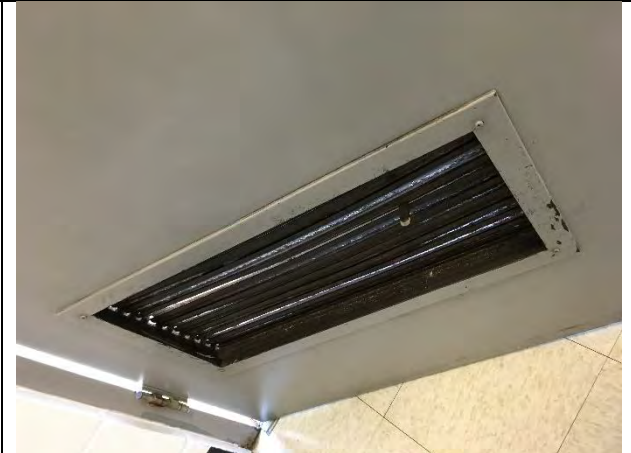
Restroom door louver
